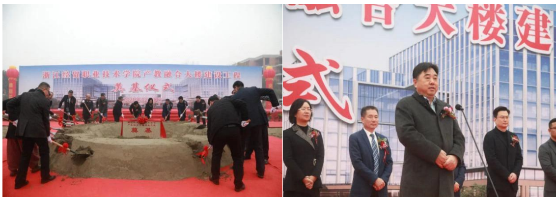
浙江经贸职业技术学院产教大楼建设工程奠基仪式
